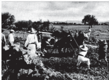
Caretera Panamericana en el camino a la Cd. México, durante su construcción ca.1932. Fuente: Franck and Lanks, 1940.
