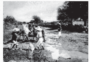
Carretera Panamericana en el camino a la Cd. México, durante su construcción ca.1932. Fuente: Franck and Lanks, 1940.
