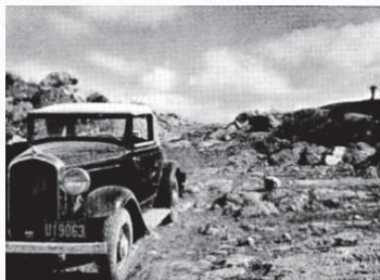
Carretera Panamericana en el camino a la Cd. México, durante su construcción ca.1932. Fuente: Franck and Lanks, 1940.
